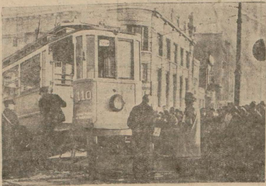
Bu sabah Köprüde sakatlanan tramvay ve tamir işleri
